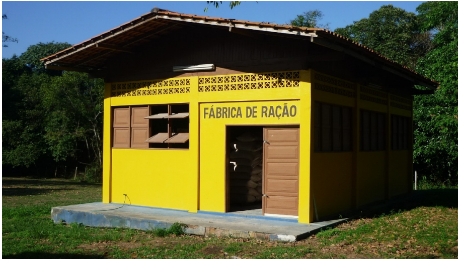
Figura 1 - Vista frontal de uma pequena fábrica de ração
