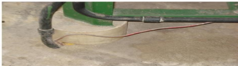
Instalar fio terra no misturador de ração.
